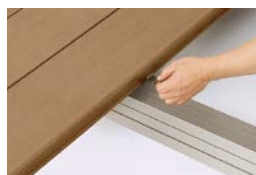
①横止め部品を床板に当てるようにセットします。
