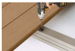
②大引に横止め部品を固定します。
