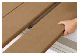
③横止め部品に引っ掛けるようにして次の床板をはめ込みます。
